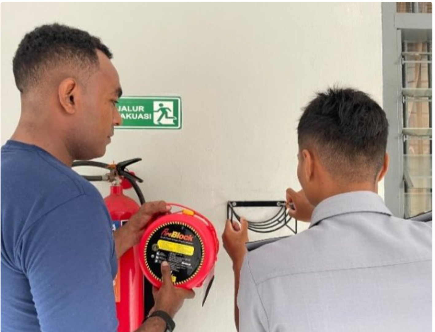
Antisipasi Kebakaran, Lapis Besi Tambah Pemasangan Fireblock
