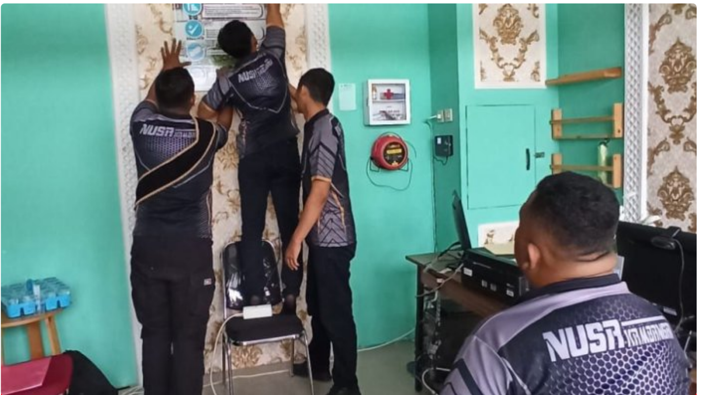
Kabapas dan Staff Renovasi Ruang Baladewa
